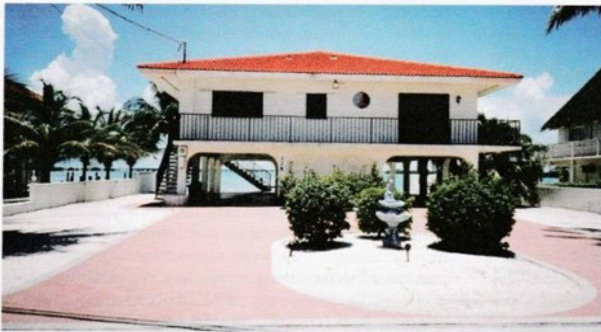
◀ **FIGURA 8.29 CASA RESISTENTE A LOS HURACANES** Casa en los Cayos de Florida construida con bloques resistentes y con espacio por debajo de la zona destinada a vivienda para permitir que el oleaje de la tormenta de un huracán pase a través del edificio. (Edward A. Keller.)
